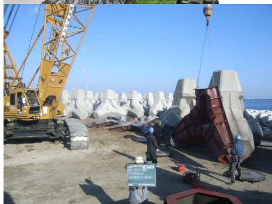
H22 年度鹿島港中央防波堤消波・被覆他工事
