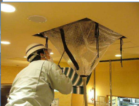
高圧洗浄にて清掃作業
