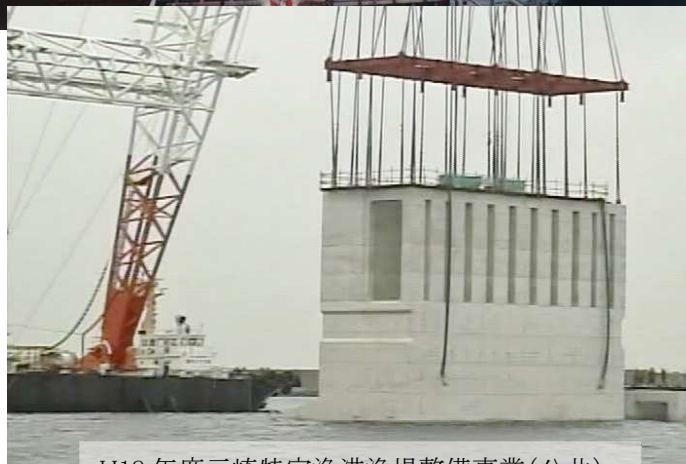
H18 年度三崎特定漁港漁場整備事業(公共) 二町谷西防波堤工事(その1)
