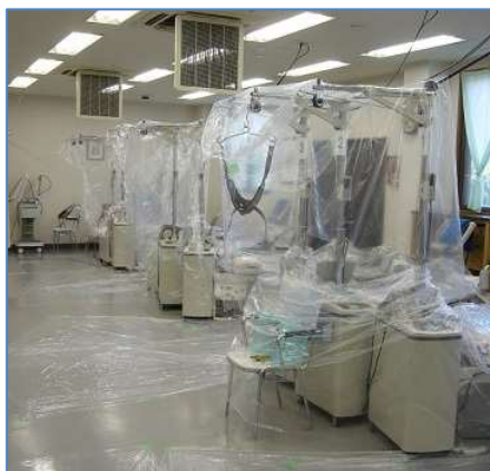
室内養生風景
