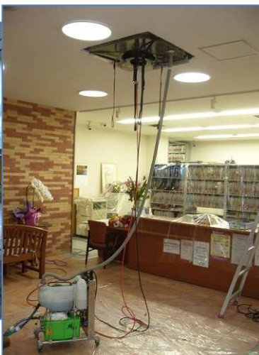
超高压エアコン洗浄ロボットにて洗浄作業中
