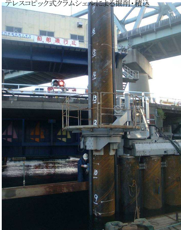
テレスコピック式クラムシェルによる掘削・積込
